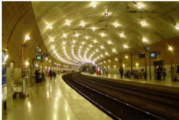
Abbildung 15: Der neue Bahnhof gab 40000 m 2 an der Oberfläche zur weiteren Nutzung frei.
