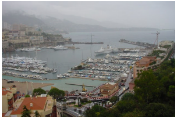
Abbildung 16: Bauarbeiten für die Hafenerweiterung
